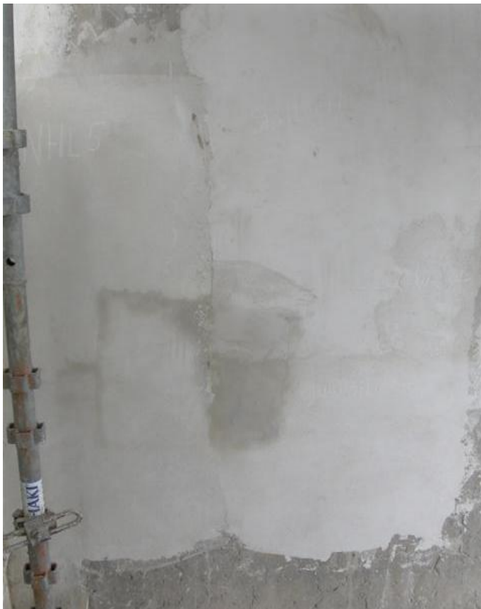
To tynne lag av finpuss (til venstre) ga bedre dekkevne enn ett lag (til høyre).
