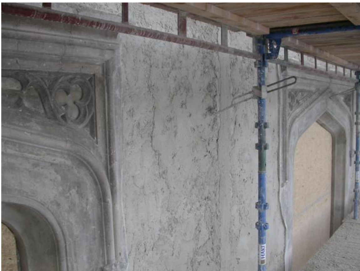
Oppbygging av veggpussen med inndeling med lirer for å angi tykkelse og oppnå en helt rett puss.
