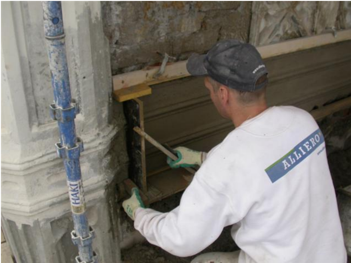
Gjenoppbygging av gesimstrekning før gjeninnsetting av frise
