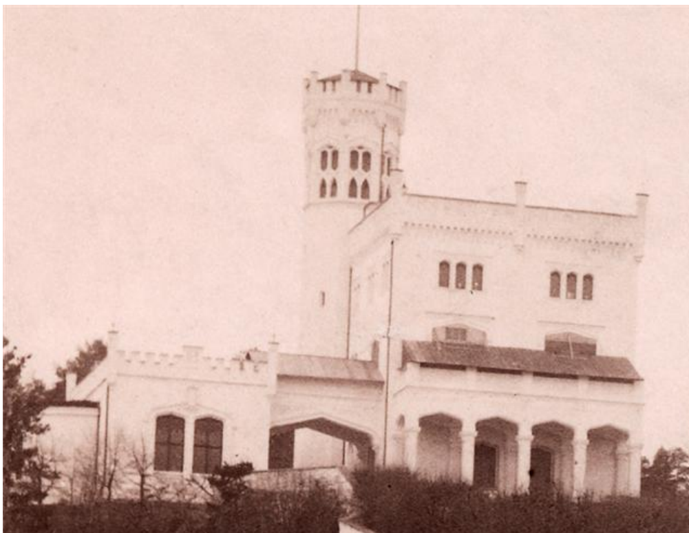
Vi ser at balkongen var dekket til for å beskytte mot nedbør. Fortsatt var det åpne takterrasser.
