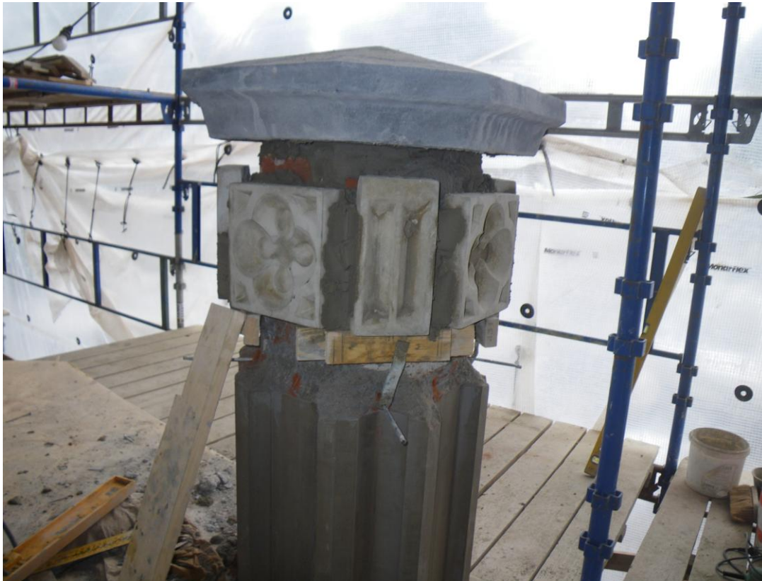
Remontering av fial. De støpte elementene av Prompt er støpt i god tid før resten av fialen ble trukket.
