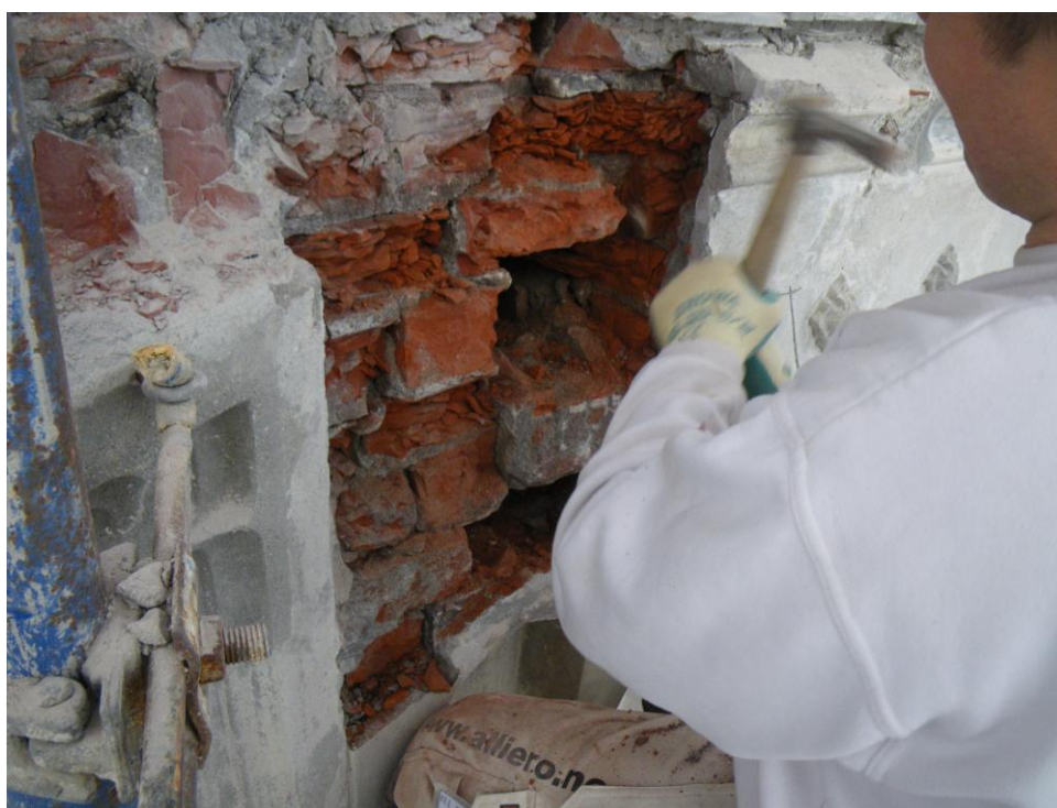
Innunder reparasjoner var underliggende teglstein fullstendig knust av frostsprengninger.
