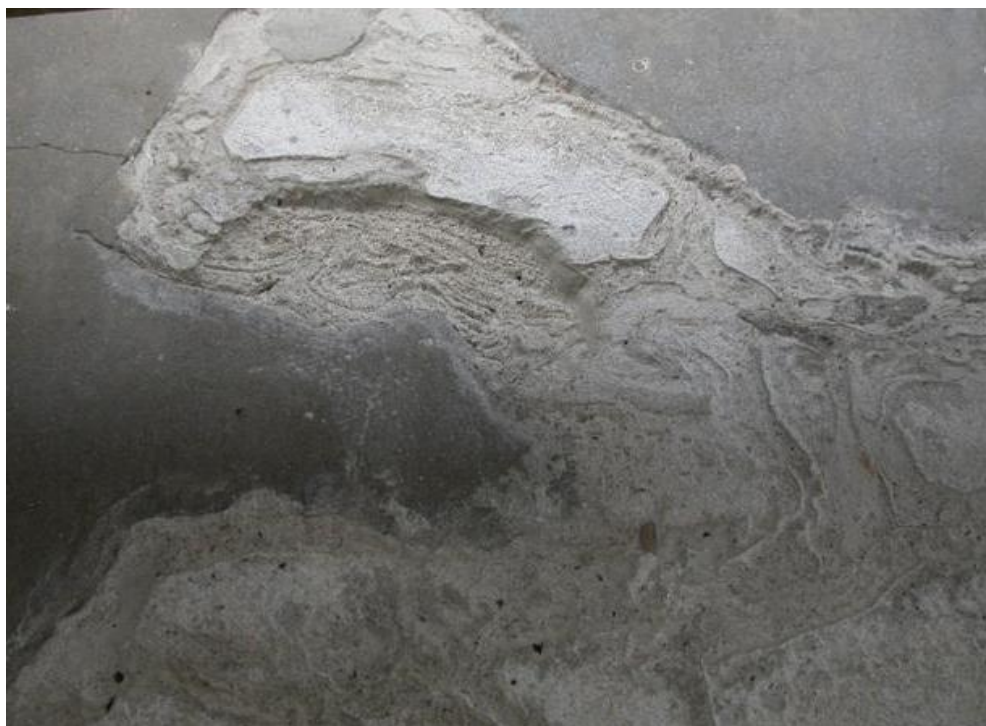
Store deler av veggflater og dekor var skiftet ut med en lysere kalksement som ikke har holdt seg så godt som den opprinnelige naturlige sementen som her sees som mørkere gråbrun.
