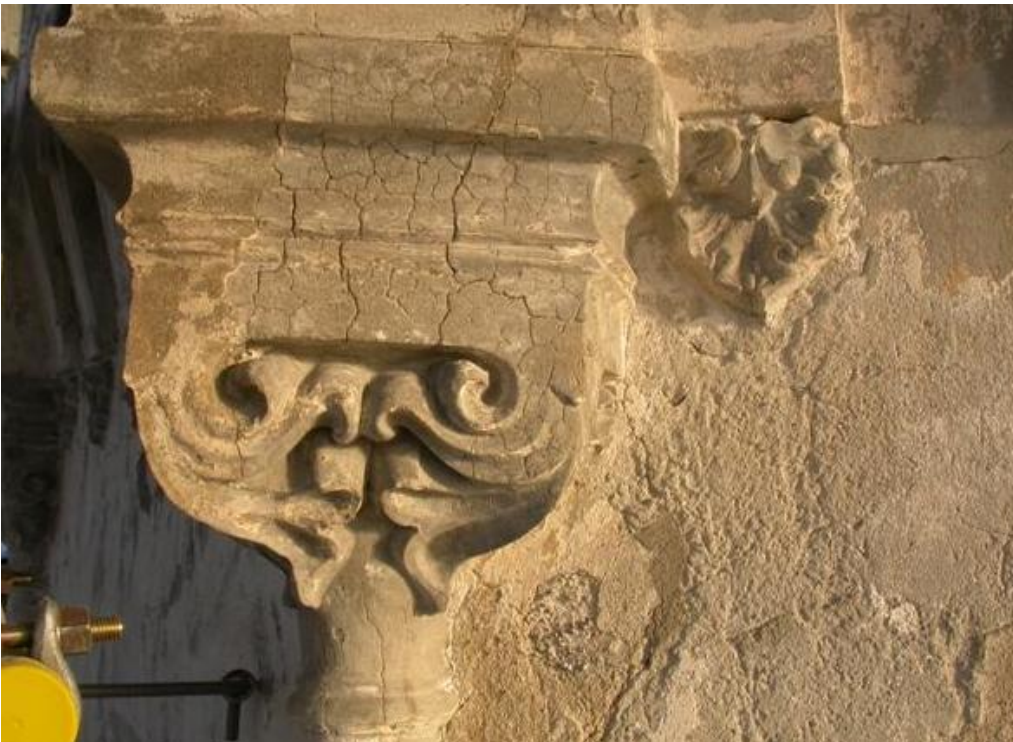
Naturlig sement kjennetegnes av omfattende riss og "sukkerbits" forvitring
